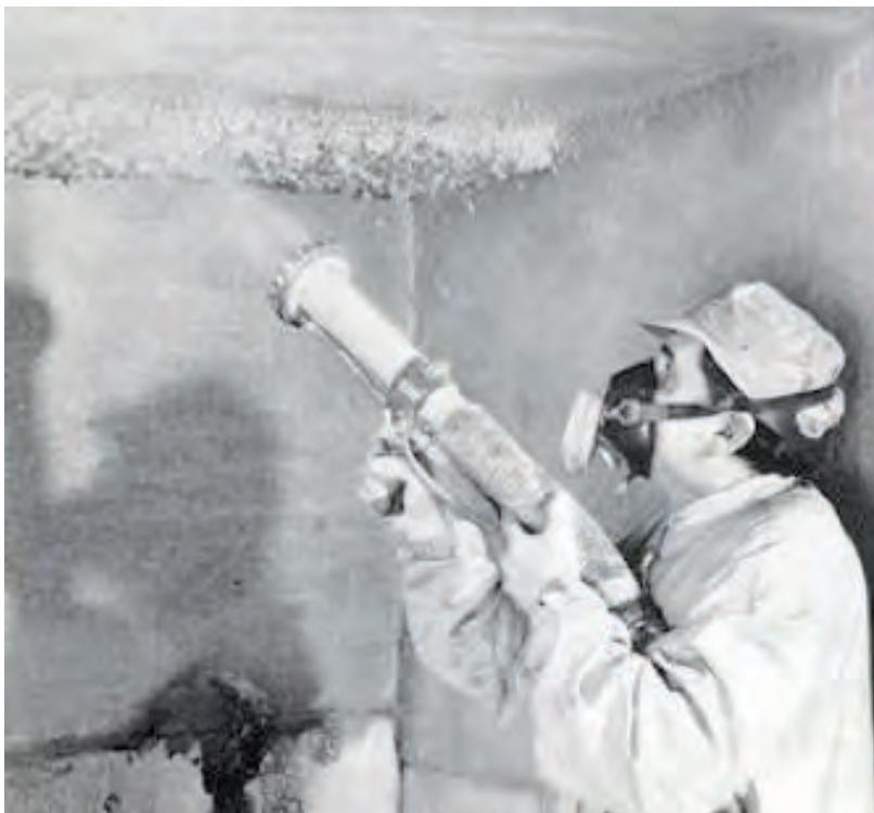
Una delle applicazioni più pericolose è la spruzzatura delle fibre libere di amianto su superfici metalliche o cementizia allo scopo di coibentazione termica, isolamento acustico o antincendio.
